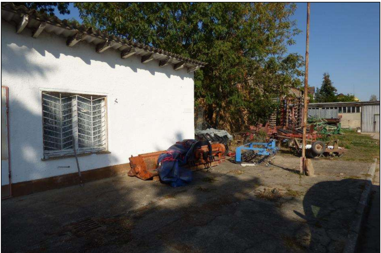
Abb. 13: Vorbereich des Tankstellenhäuschens (betonierte Fläche)
